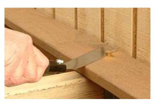
Аккуратно удалите выступающую часть деревянной заглушки, используя небольшую пилу либо ленточно- шлифовальный станок.
