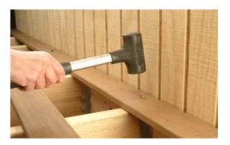
Нанесите клей и вставьте конусообразные деревянные заглушки диаметром около 9.5 мм в каждое зенкованное отверстие.
