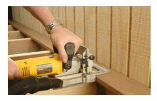
С помощью 3.2-х мм фасонной или плоскодюбельной фрезы (бисквитного резака) проделайте пазы в террасной доске на местах ее пересечения с балкой.
