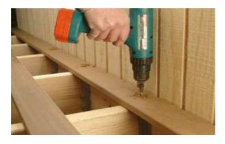
Применяйте сверло на 3.2мм с зенковкой на 9.5мм. Закрепите одну сторону первой доски, используя шурупы. Используйте нержавеющие шурупы SPAX-D с узкой шляпкой.
