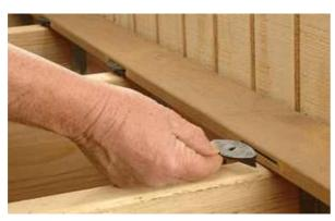
Разместите EB-TY® (ип-тай) крепления в выемках при каждом пересечении с балкой.
